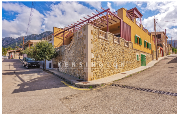
Strandhaus in Port des Canonge Aussenfassade
