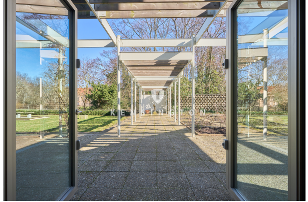
Austritt zur Terrasse
