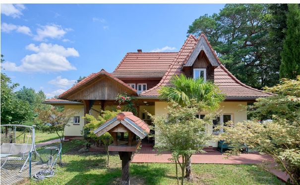
Hausansicht mit schönem Terrassen- und Gartenbereich
