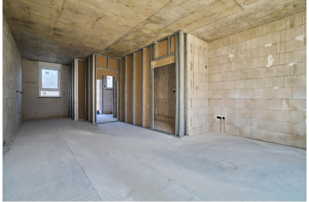
Rohbau Küche und Wohnzimmer
