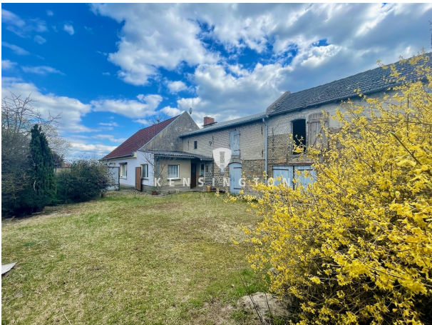
Innenhof/ Blick zum Haus
