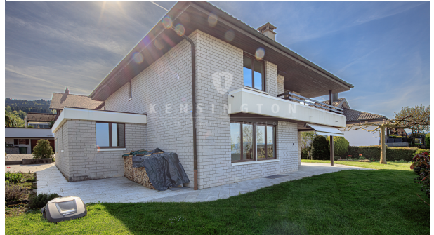
KZO00081VA Einmalige Gelegenheit - 7.5 Zimmer Einfamilienhaus an wunderbarer Aussichtslage in Wernetshausen - Ansicht Südwest
