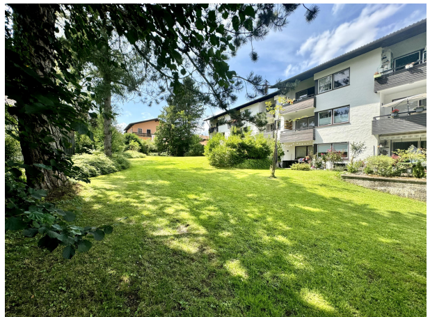
Gartenansicht auf das Haus
