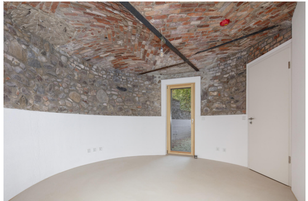
Zimmer (ehemaliger Eiskeller)
