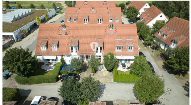
Luftblick Reihenhäuser II
