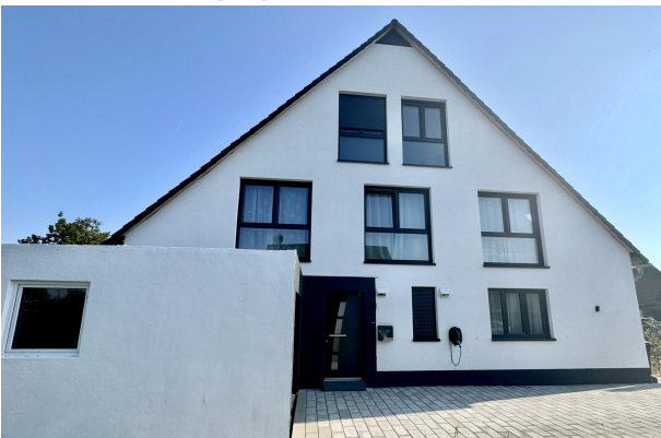
Giebelansicht Eingang Mastereinheit
