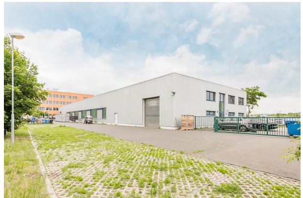
angrenzendes Grundstück mit Halle
