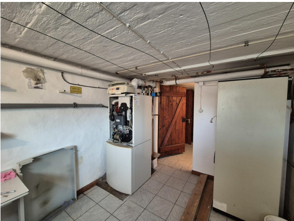
Keller mit Heizung
