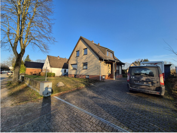
Hausansicht von der Straße aus
