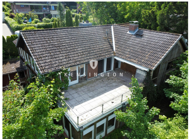
Hausansicht mit Terrasse
