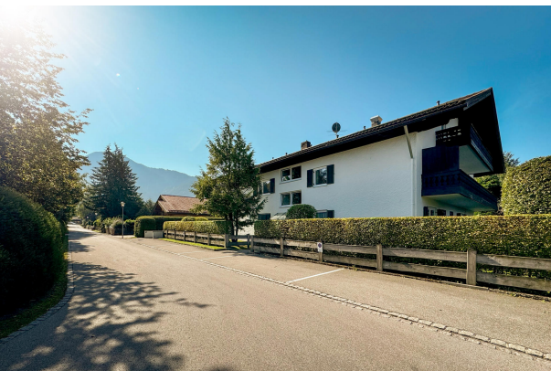
Hausansicht von der Straße aus
