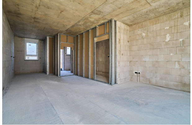
Rohbau Küche und Wohnzimmer
