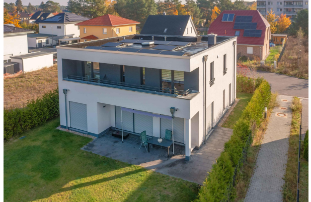
Ansicht von hinten
