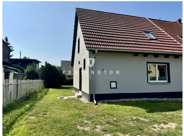
Haus mit Vorgarten von Vorne
