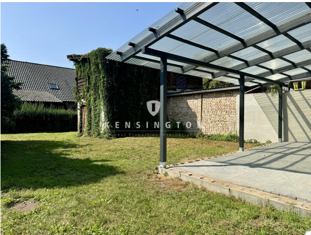
Schuppen und überdachte Terrasse
