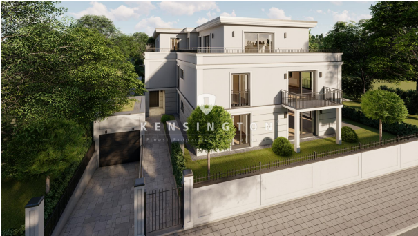
Außenansicht von der Straßenseite
