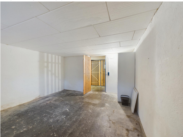
Eigener, großzügiger Kellerraum.
