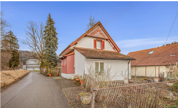
KZO00080 Knusperhäuschen zum Verlieben - Ansicht West
