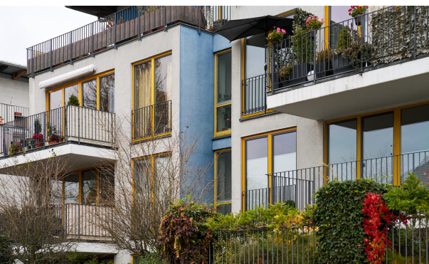
Ansicht der Hausfassade mit liebevoll gestalteten Privatbalkonen
