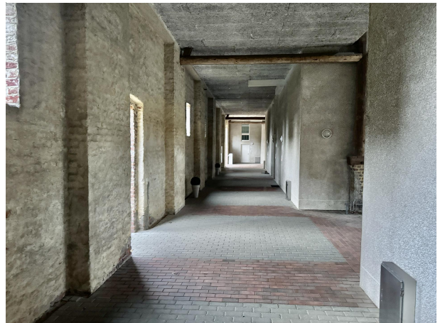
Zugang zu den Wohnungen Ostflügel
