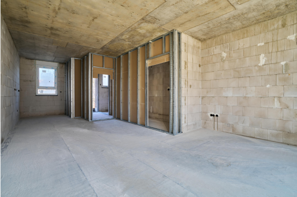
Rohbau Küche und Wohnzimmer
