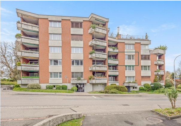
KZO00074E Ruhig gelegene 3.5 Zimmer Wohnung mit Sicht auf den Pfannenstiel - Aussenansicht
