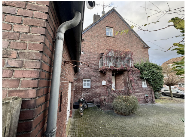
Giebel links Hauseingang mit Hof
