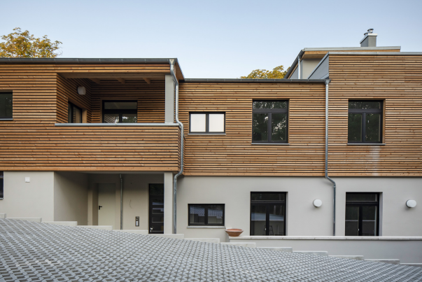
Fassade Ost Eingang B
