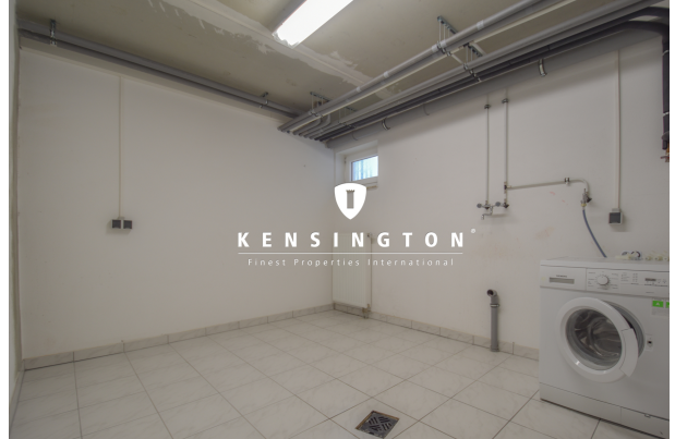
KSW238-Einfamilienhaus in Essingen-Waschraum
