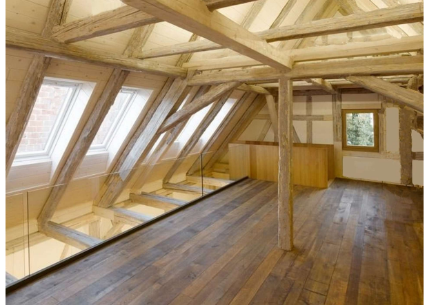
Beispielbild nach der Sanierung
