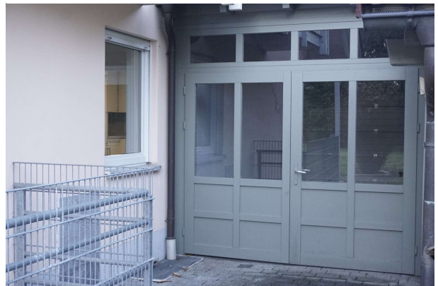
kleine Garage Zugang vom Garten aus
