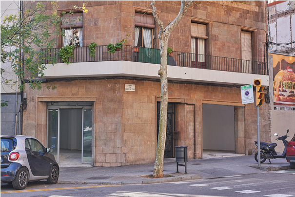
Fachada izquierda y derecha
