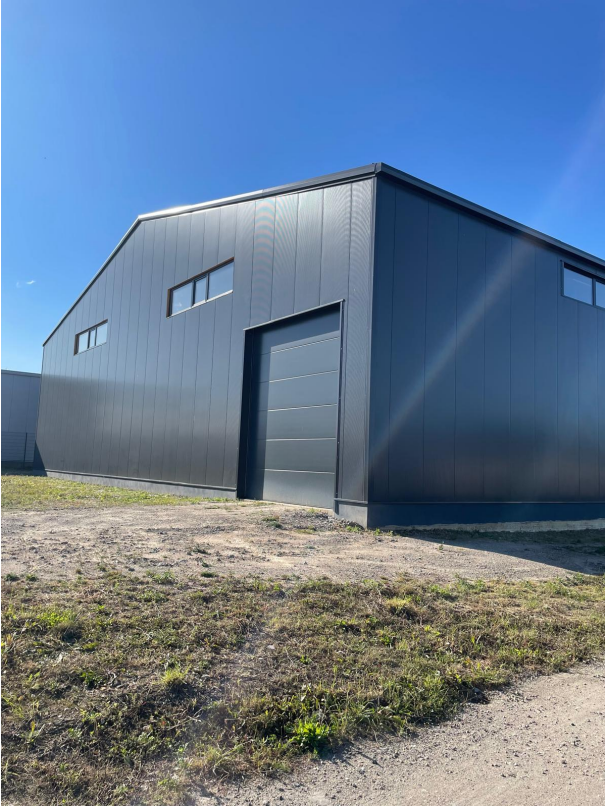
Halle Ansicht Hinten
