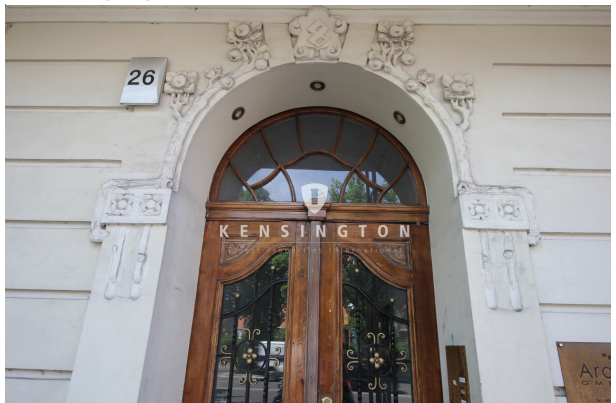
Hauseingang, rechtes Haus
