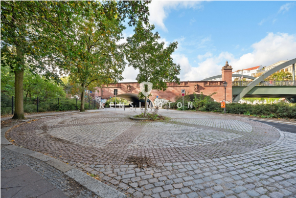
Brücke über die Spree
