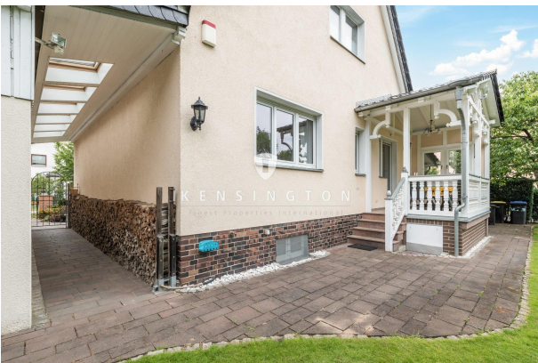
Hausansicht Rückseite mit Veranda
