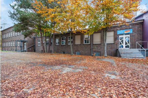
Gebäudeansicht von der Seite
