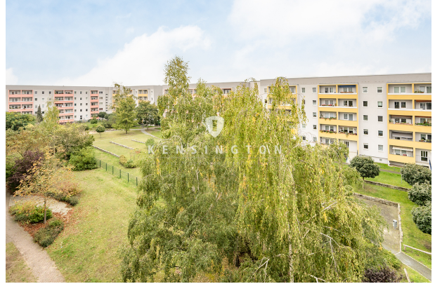
Blick zum Innenhof
