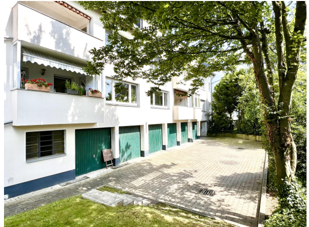
Rückwärtige Ansicht und PKW-Garagen
