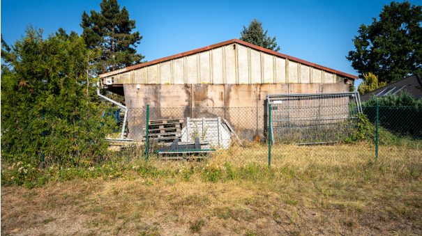
Straßenansicht mit Abrissobjekt
