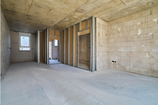
Rohbau Küche und Wohnzimmer
