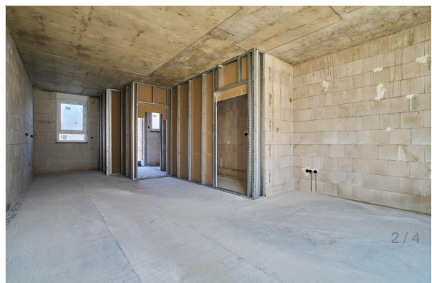
Rohbau Küche und Wohnzimmer
