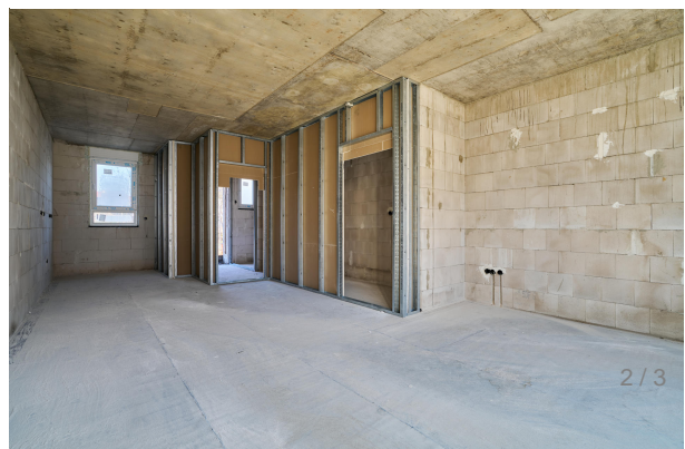
Rohbau Küche und Wohnzimmer
