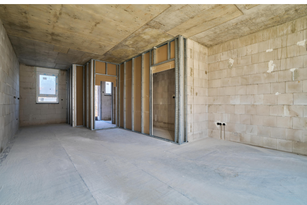
Rohbau Küche und Wohnzimmer
