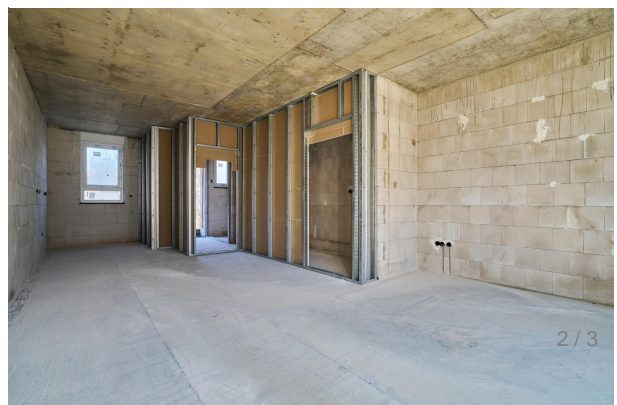
Rohbau Küche und Wohnzimmer
