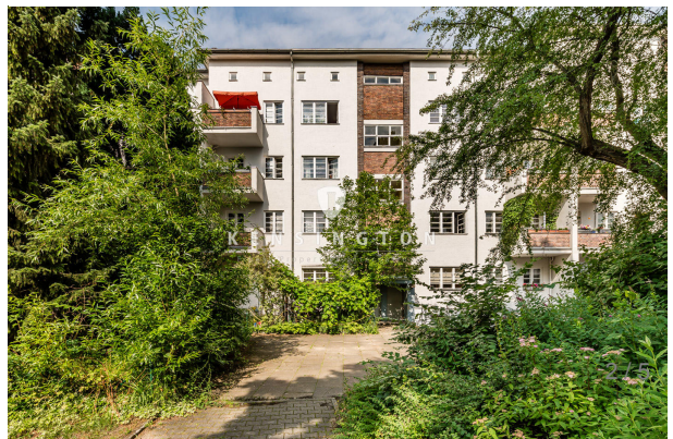
Hof- und Gartenansicht
