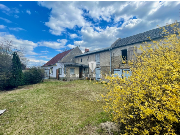
Innenhof/ Blick zum Haus
