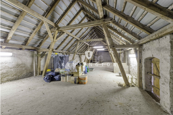
Ausbaufähiges Dachgeschoss in der Remise
