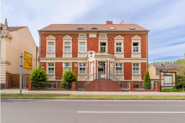
Wohnhaus von Straßenseite
