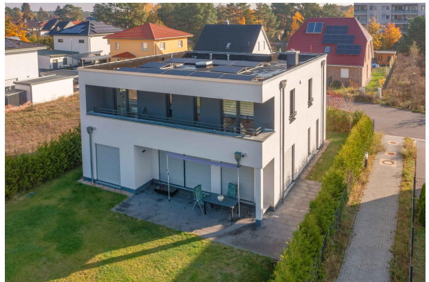
Ansicht von hinten
