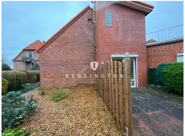
Außenansicht Garten und Terrasse
