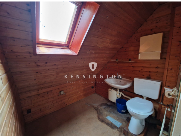
WC auf dem Dachboden
